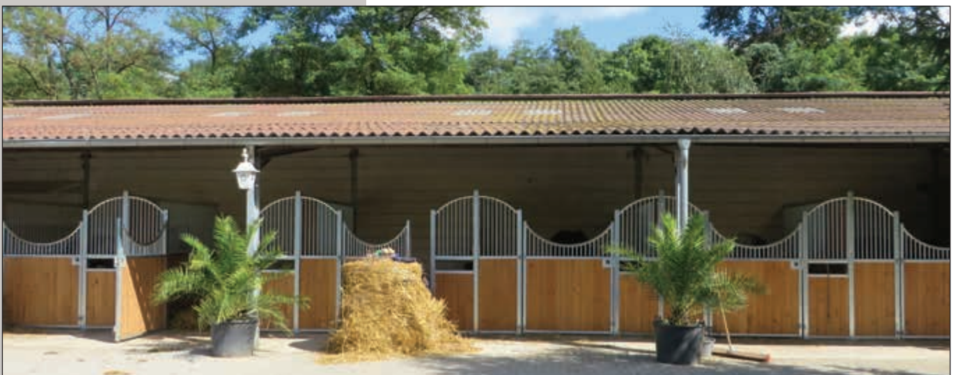
Façades « Nordsee » avec bois Douglas, comme boxes extérieurs
