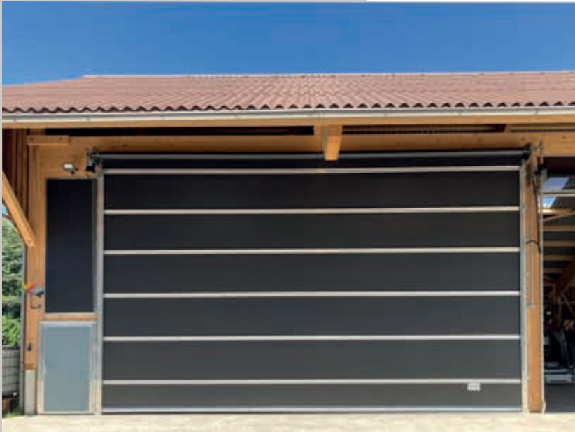
Protection contre les intempéries
