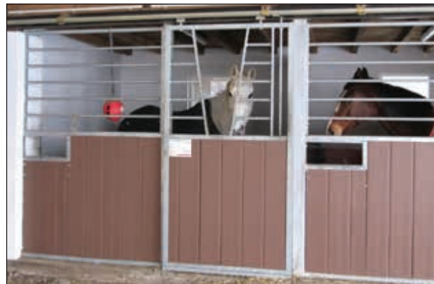
Box « Bavaria » avec col de cygne dans la porte et remplissage PVC.
