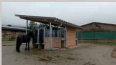
Station de nourrissage avec automates pour concentrés
