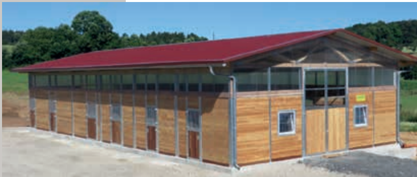
Freitragender Stall mit Nagelbindern
