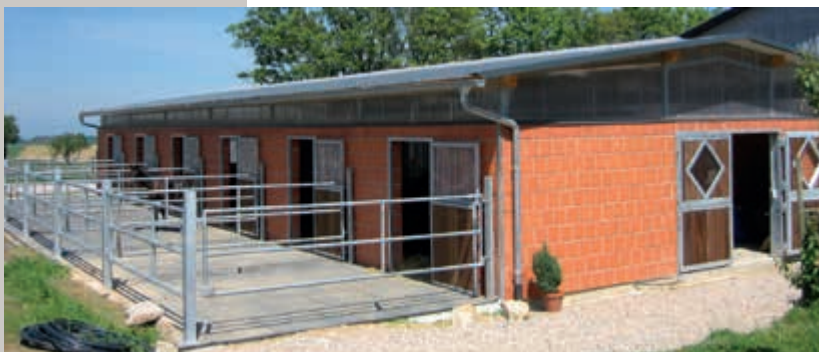
Pferdestall Modul mit Sichtmauerwerk
