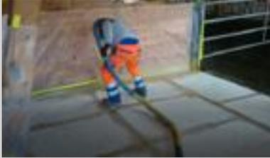
Les revêtements Elastikspray sont appliqués rapidement et sèchent en quelques secondes
