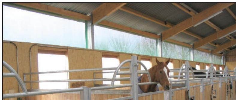
Filet brise-vent - Fixation avec des tasseaux en bois (sur site), œillets de fixation ne sont pas compris.
